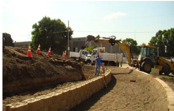
(d) Terraced bioretention cells in Ames under construction.
