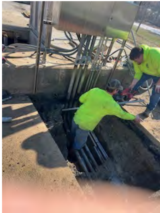
Repairing Conduits
